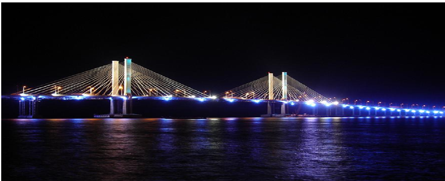
Ponte sobre o Rio Acre
