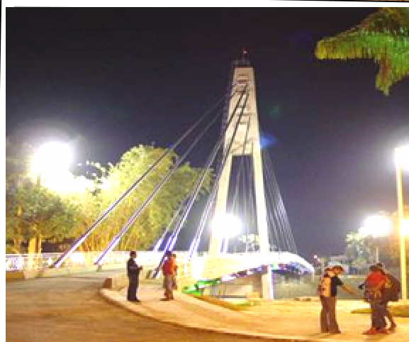
• Ponte binacional Brasil - Bolívia
